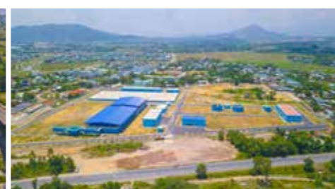
Nhà máy nước Hòa Liên - Đà Nẵng
